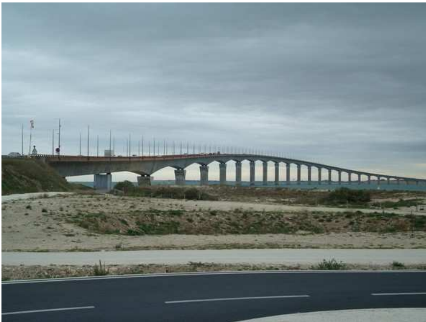
Pont de l'île de Ré dans toute sa splendeur
