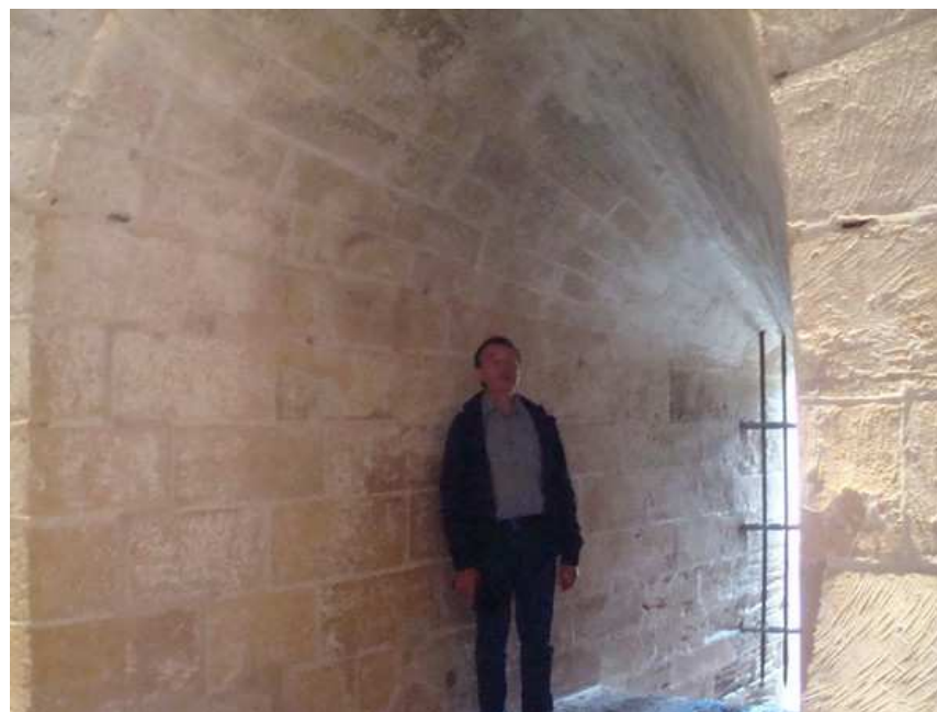
et murs à toute épreuve (notre ami dans l'épaisseur du mur !!)
